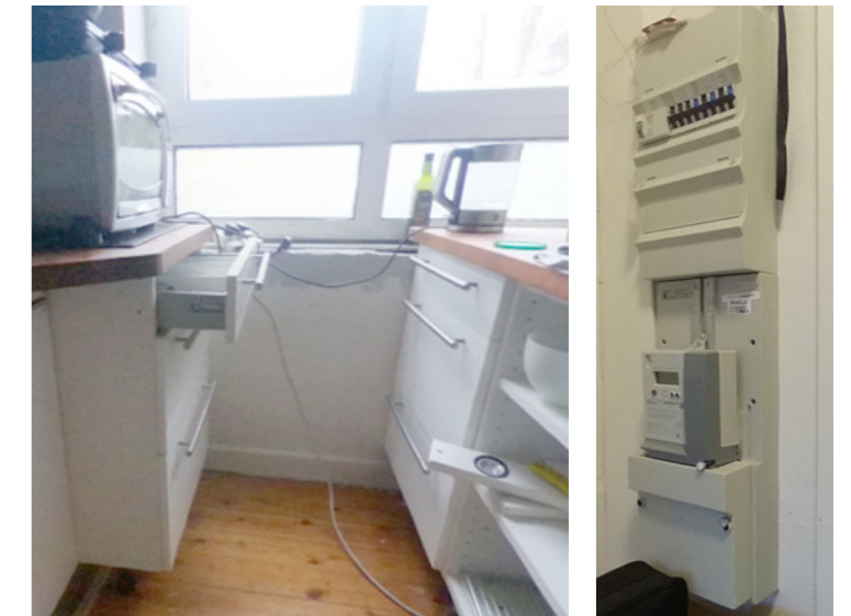
El-installationerne og tavlerne udbygges og omlægges
