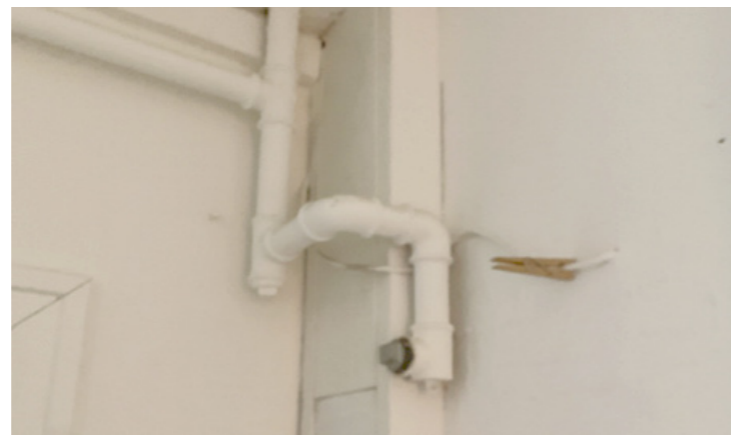
Gasinstallationerne nedlægges
